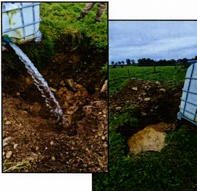
BRE 365 TEST HOLE
