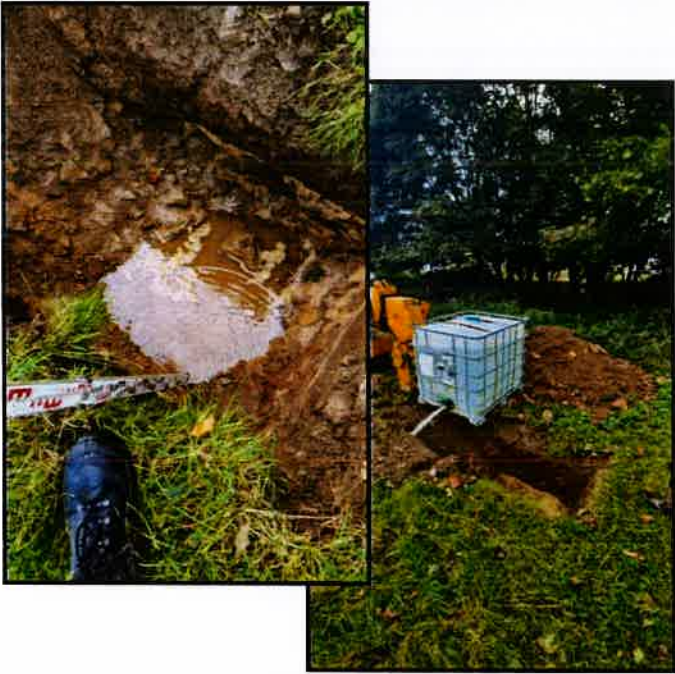
BRE 365 TEST HOLE
